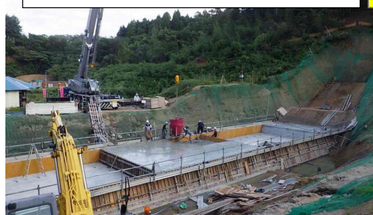
砂防堰堤工 (型枠・コンクリート)
