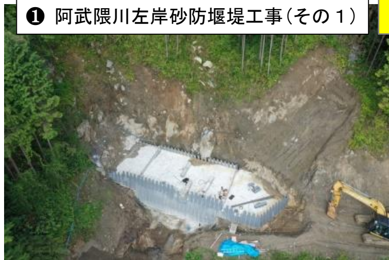
砂防堰堤工 (型枠・コンクリート)
