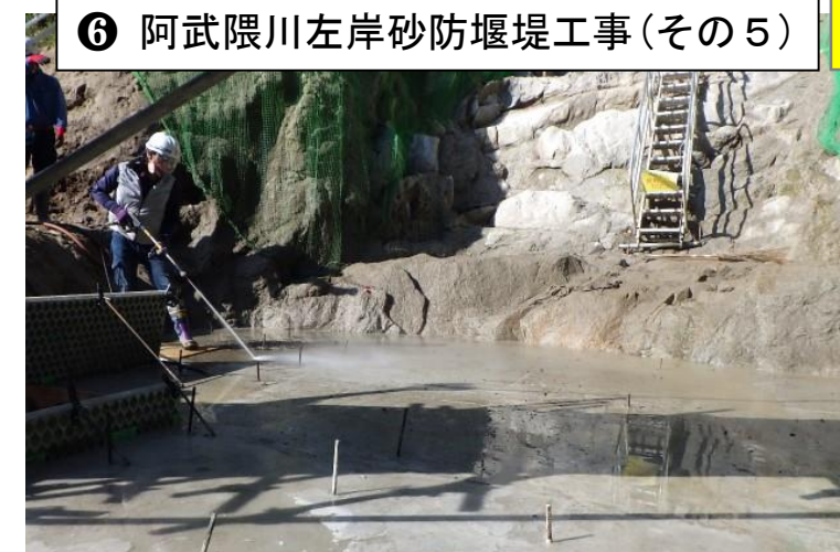
砂防堰堤工 (型枠)
