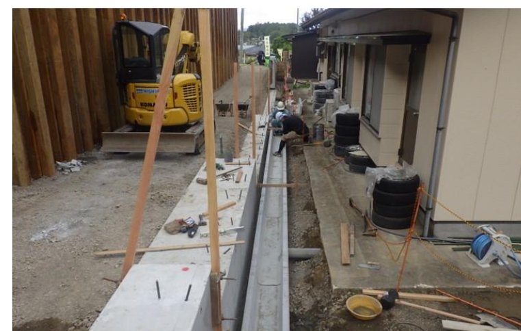
工事用道路 (補強土壁前面排水)
