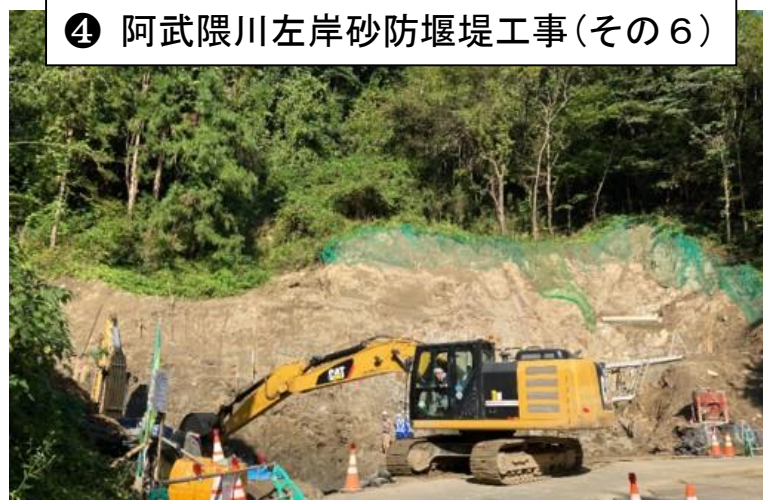
砂防土工 (掘削)
