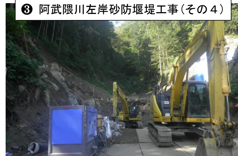
砂防土工 (掘削)
