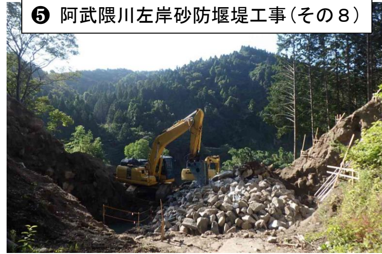
砂防土工 (掘削)
