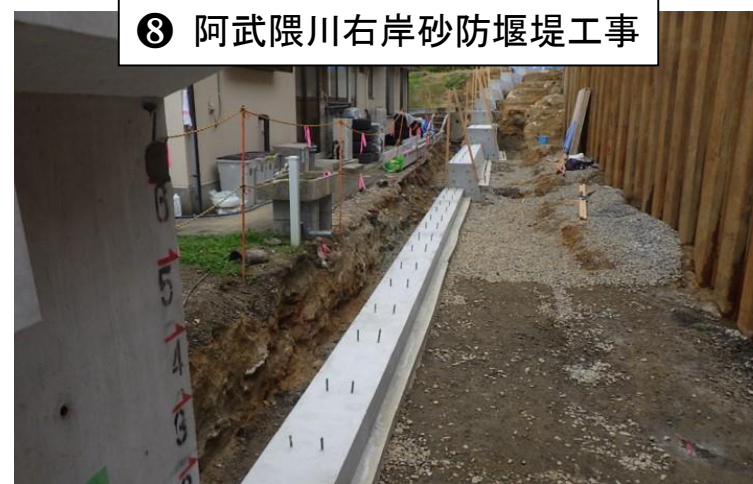
工事用道路 (補強土壁基礎)
