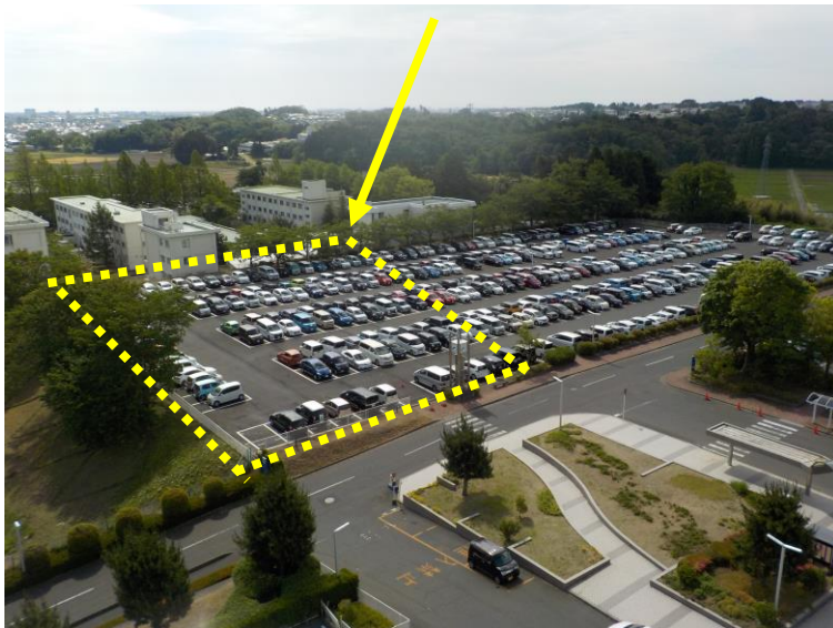
駐車場増設箇所
