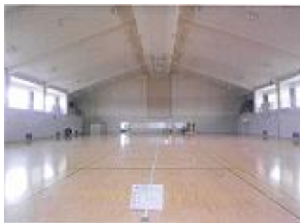
講堂天井改修（着手前）
