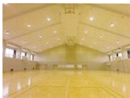
講堂天井改修（完成）
