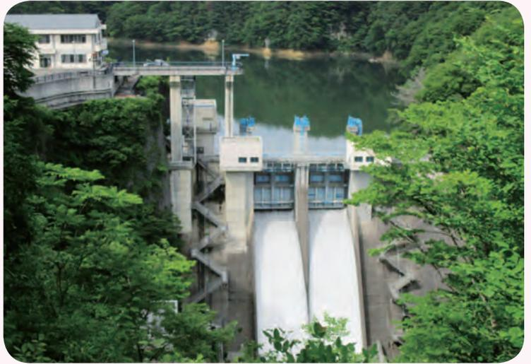
迫川は、昭和の初期から河川改修が進められてきましたが、昭和 22 年 9 月のカスリン台風、昭和 23 年 9 月のアイオン台風等で流域に大きな被害が発生したため、迫川総合開発事業の一環として花山ダムが計画されました。花山ダムは、迫川上流に多目的ダムとして、昭和 27 年から 6 年の歳月と約 16 億円をかけ、昭和 33 年 1 月に完成した、宮城県が手掛けた最初の重力式コンクリートダムです。近年の生活様式の変化や下水道の普及による水不足に対応するとともに、老朽化した各施設を更新するため、平成 3 年度から平成 16 年度まで花山ダム再開発事業並びに施設改良事業を実施しました。
