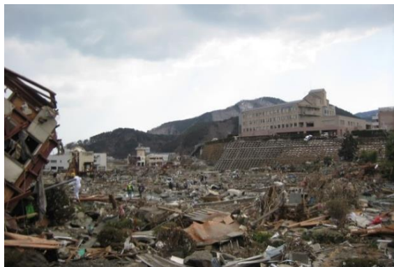
女川町の被害状況
