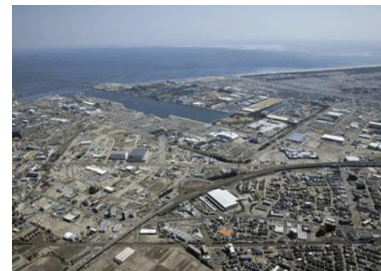
（被災後の仙台港周辺）
