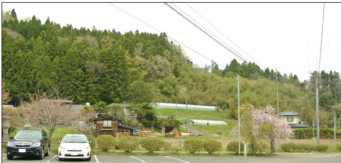
周囲の自然から突出せず山並みに馴染む高さの建築物
