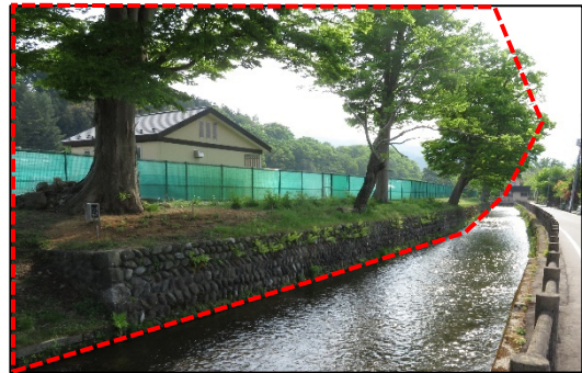
沢端川沿いの植栽や自然石を活用した護岸
