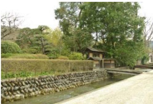
▲掘割と武家屋敷地（白石市）
