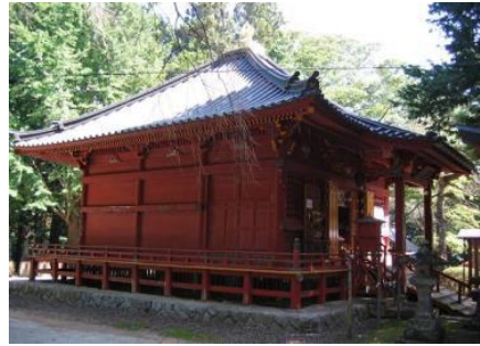
▲斗蔵寺観音堂（角田市）
