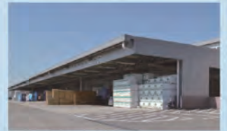
仙台国際貿易港物流ターミナル
