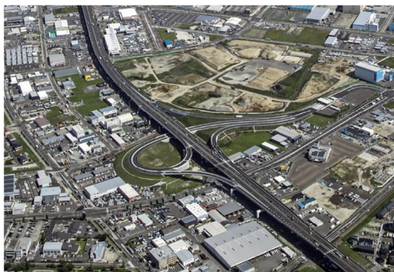
事業区域内に整備された仙台港インターチェンジの全景
