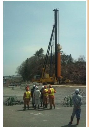
SDM-Dyによる地盤改良 (深層混合処理)状況
