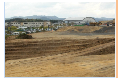
病院・ケアセンター建設予定地の造成
