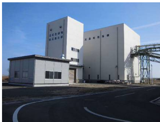
(汚泥燃料化施設)
