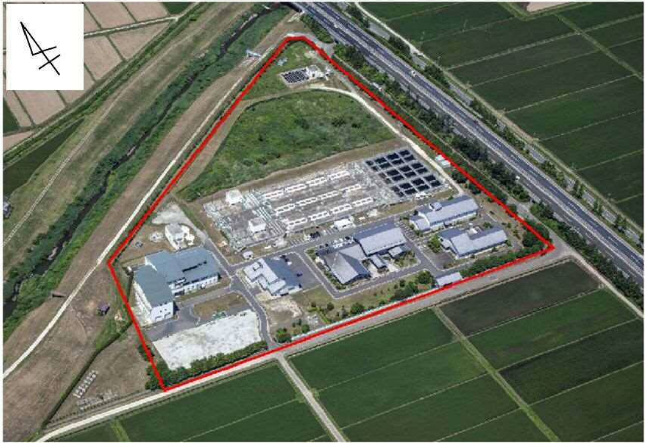
大和浄化センター全景写真（赤線部分が敷地）
