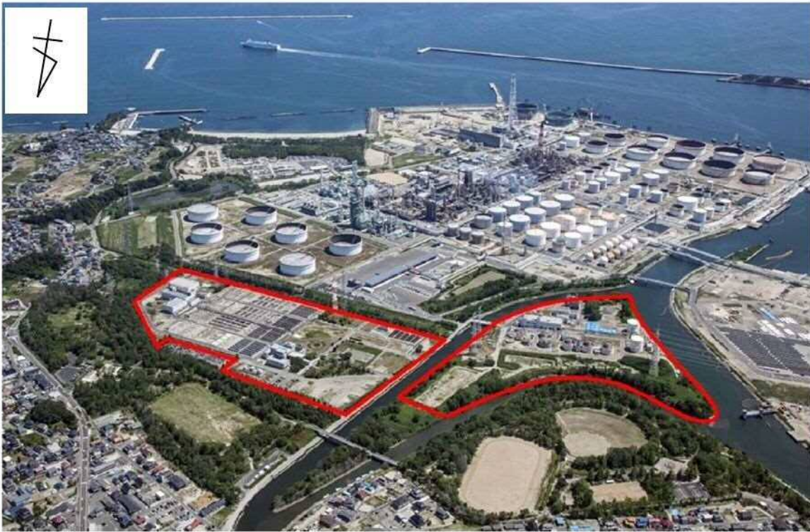
仙塩浄化センター全景写真（赤線部分が敷地）
