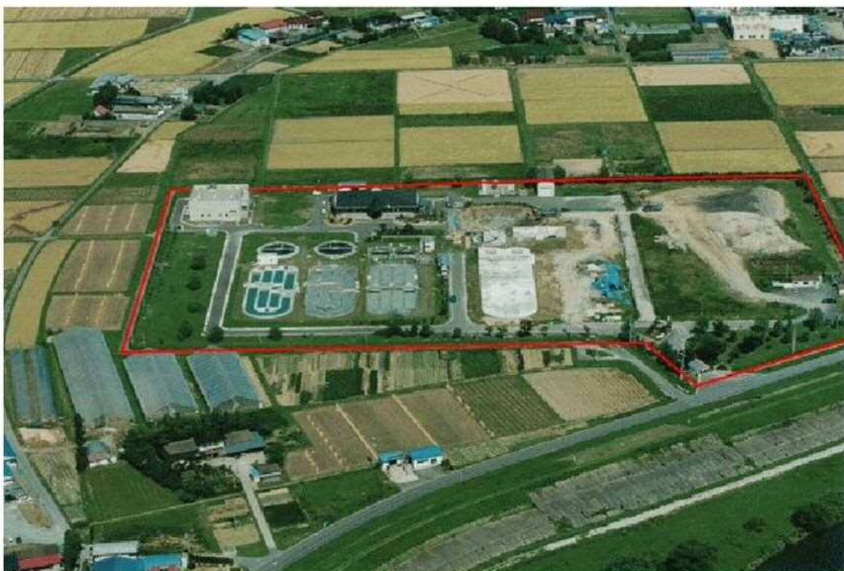
鹿島台浄化センター全景写真（赤線部分が敷地）
