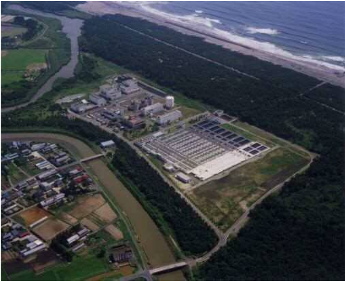
県南浄化センター全景写真
