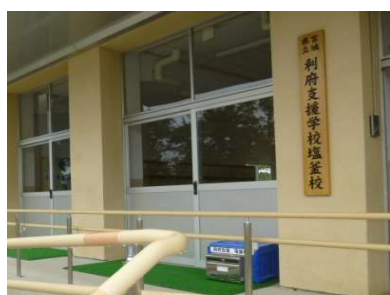
小学校の余裕教室を活用した 分校の設置 (利府支援学校塩釜校)
