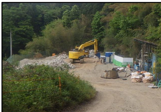
写真: 土間コンクリート撤去状況
