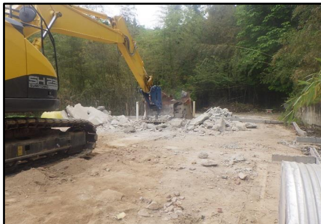
写真: 煙突基礎解体状況
