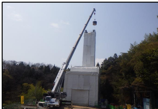
写真: 煙突撤去状況
