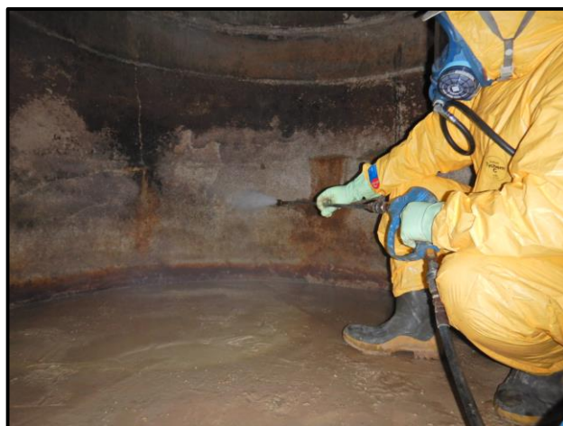
写真: 煙突除染状況
