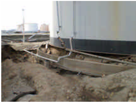
図 5.1.11 津波による屋外タンク基礎部及び防油堤の洗掘
