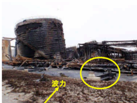
図 5.1.16 LPG パイプラック基礎及び配管の損傷
