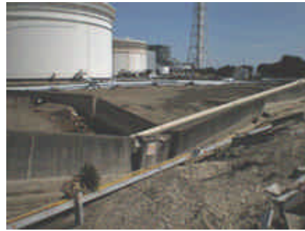
図 5.1.11 津波による屋外タンク基礎部及び防油堤の洗掘
