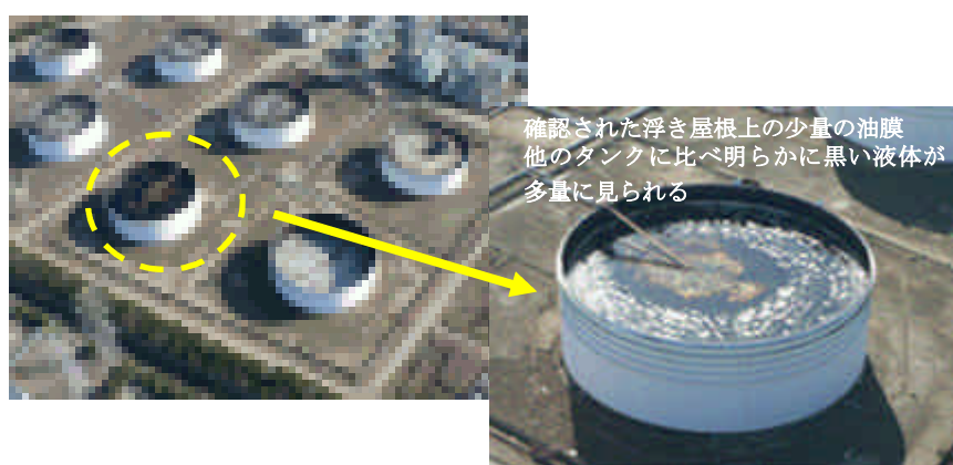
図 4.1.1 浮き屋根上に原油溢流疑いの事例
