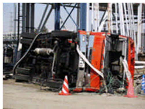
図 5.1.15 津波による消防車両の被害
