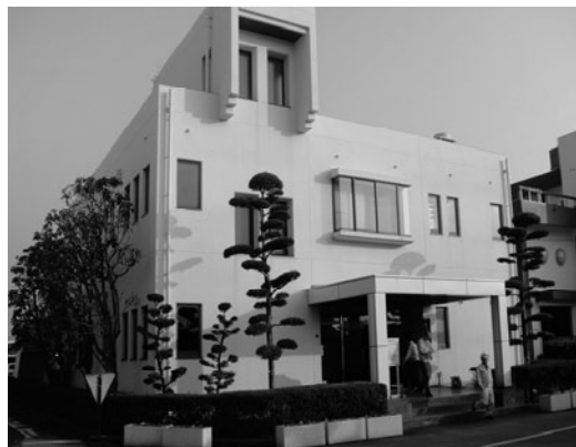
熊本市上下水道局中部浄化センター
