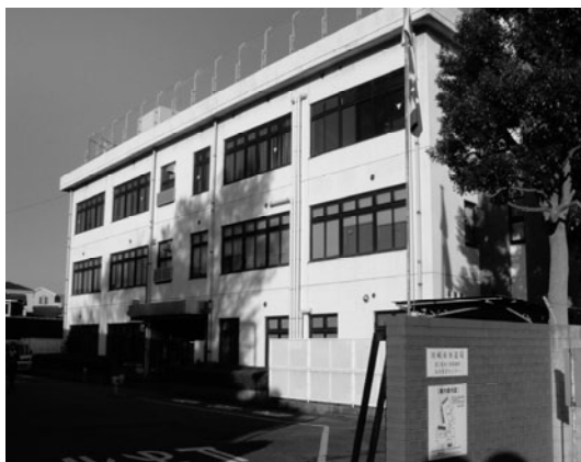
川崎市水道局第1配水工事事務所
