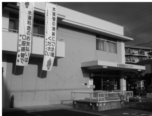
神戸市水道局垂水センター
