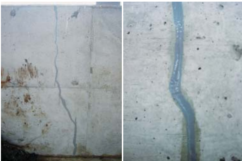
ヒビ割れの補修例
