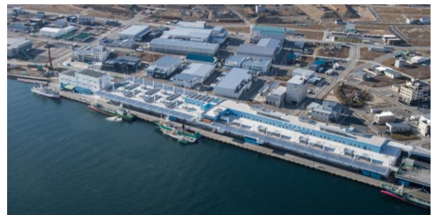
地方卸売市場気仙沼市魚市場完成状況
