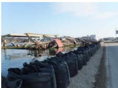
荷さばき所の被災状況
