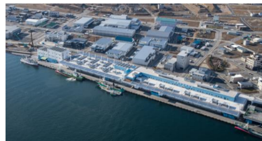
完成した地方卸売市場気仙沼市魚市場
