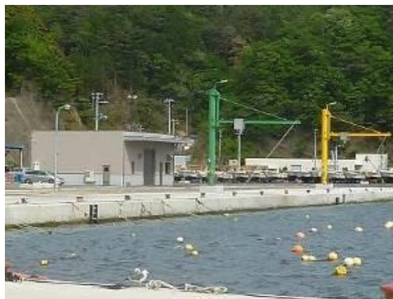
・水産物荷捌き施設と荷揚げクレーン
