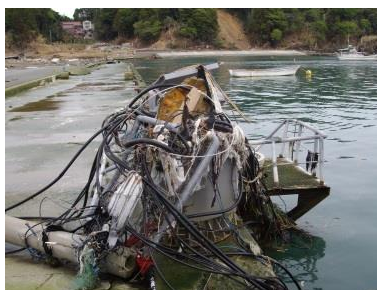
図2 被災した歌津観測所
