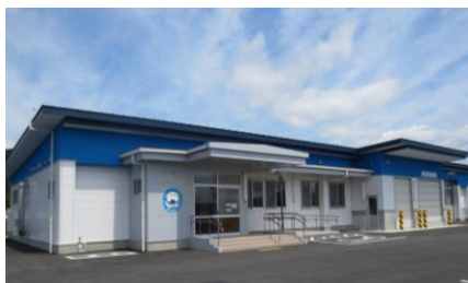
水産加工公開実験棟
