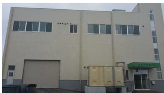
復旧した水産加工施設
