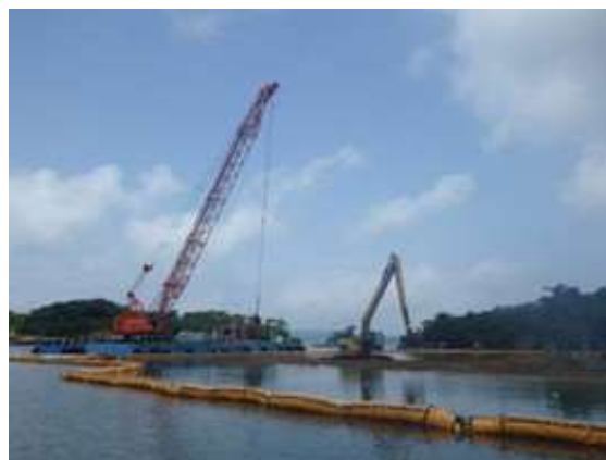
松島湾野々島工区(施工中)
