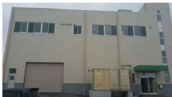
復旧した水産加工施設
