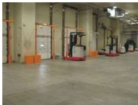
復旧した冷凍冷蔵施設
