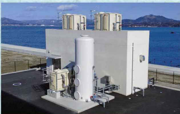
取水ポンプ棟
