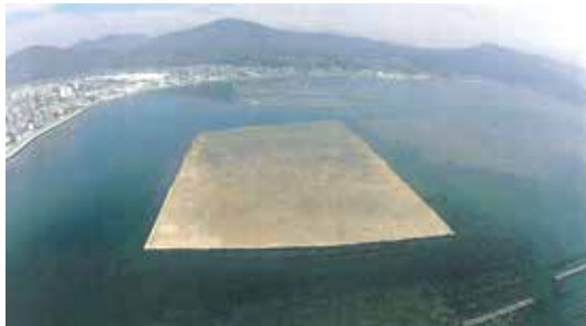
写真3 万石浦石巻地区工区（平成27年度完成）
