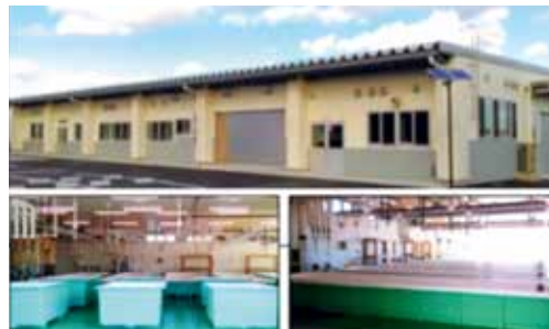
写真 種苗生産施設
