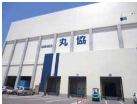
写真 冷凍冷蔵施設
