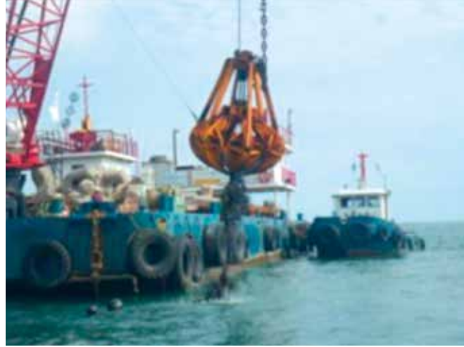
写真 漁場ガレキ撤去作業（平成25年9月10日）
