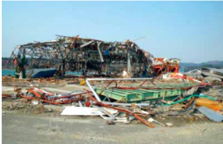
写真 荷さばき施設被災状況
