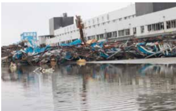
写真 荷さばき施設被災状況
