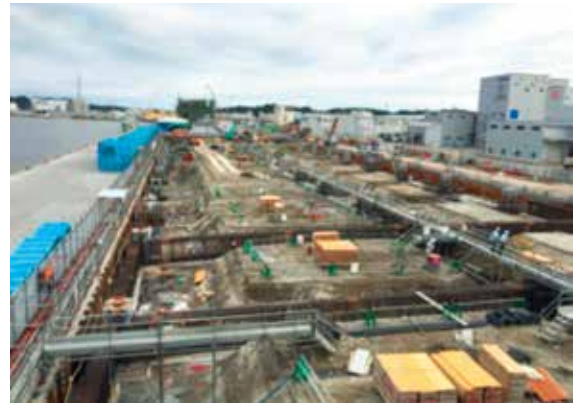
写真 荷捌き施設の施工状況（H28.9月）
