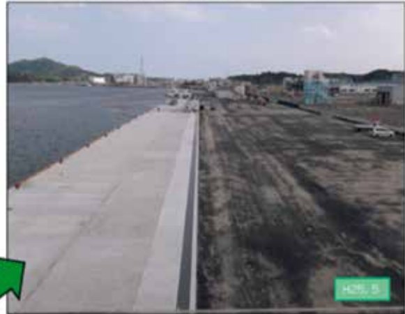
-6.0m岸壁施工状況（直轄代行事業）
