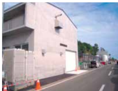
写真 倉庫兼電気室棟
