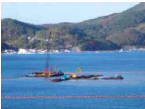
写真 造成工事の様子（石巻湾地区）
