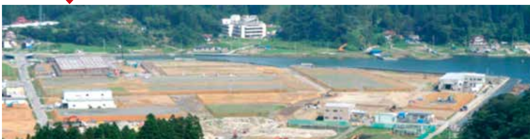
写真 鹿折地区 嵩上げ完了状況（平成26年8月22日撮影）
