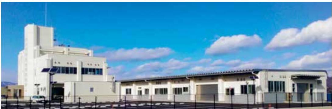
写真 完成した新気仙沼水産試験場（気仙沼市波路上岩井崎）
