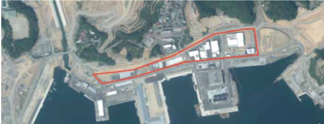
写真 女川地区 嵩上げ完了状況（平成27年）
