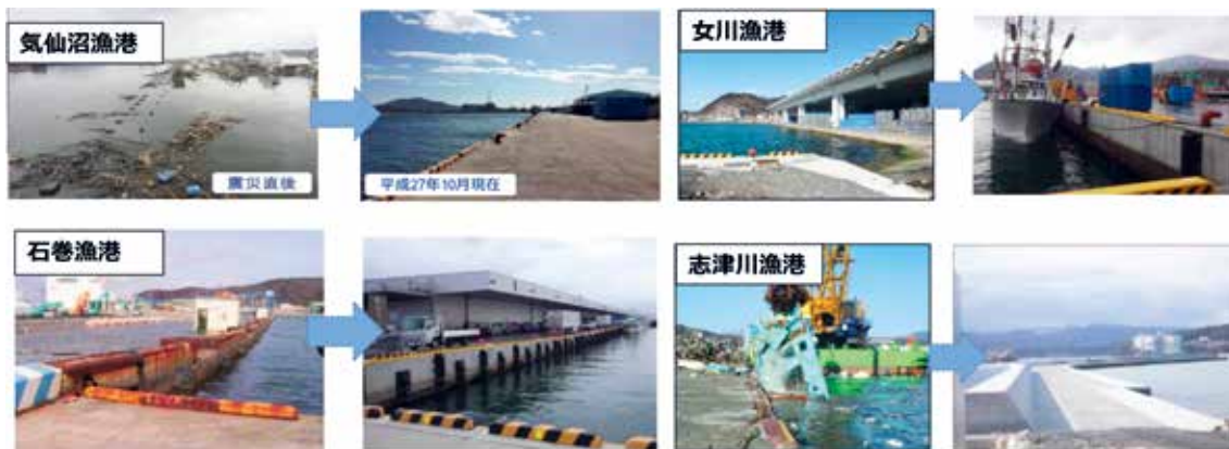
写真 震災直後からの漁港復旧の様子（気仙沼漁港、石巻漁港、女川漁港、志津川漁港）
