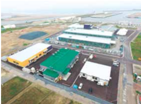
写真 第1期分完成状況
