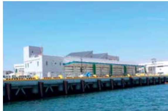
写真 荷さばき施設（B棟）完成状況
