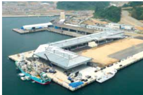
写真 荷さばき施設（東棟）完成状況
