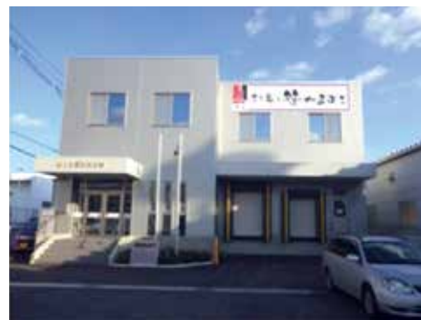
写真 水産加工施設（蒲鉾工場）
