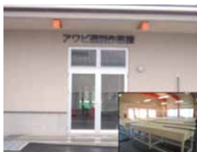
写真 アワビ選別作業棟
