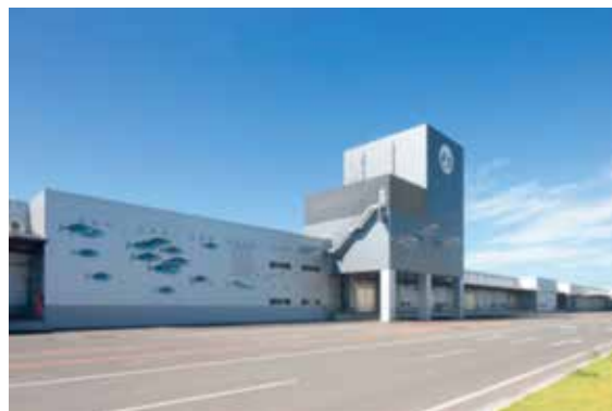
写真 荷捌き施設完成状況
