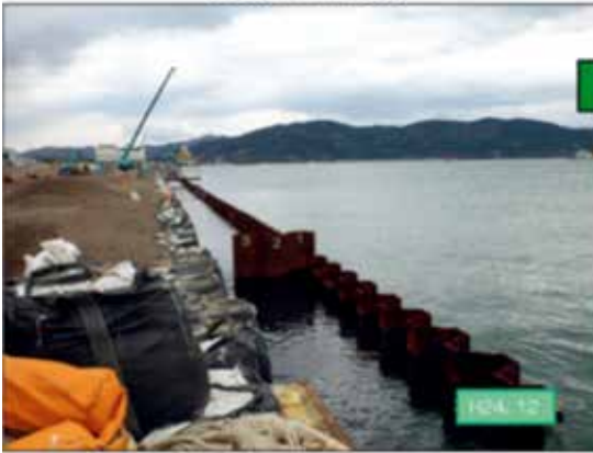
石巻漁港 -7.0m岸壁復旧状況 (直轄代行事業)
