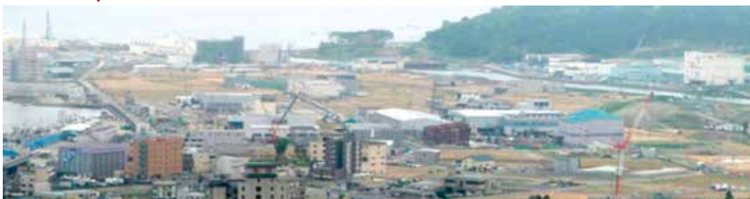
写真 南気仙沼地区 嵩上げ完了状況（平成27年6月26日撮影）
