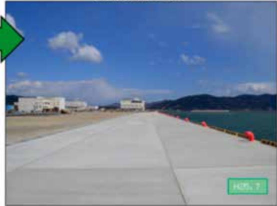
石巻漁港 -7.0m岸壁復旧状況 (直轄代行事業)
