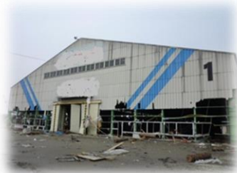
被災した木材加工施設
