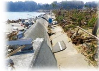
被災した防潮堤と海岸林
