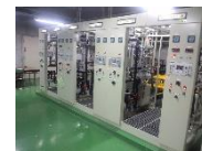
設備(資産の3割) 維持管理・更新工事
