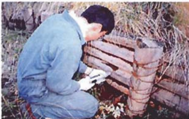
写真1. 現地調査状況 (ピロディン測定)
