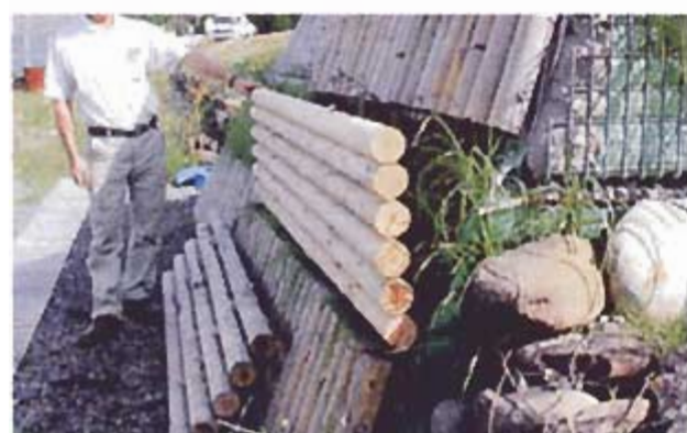
写真8. 新間伐材取り付け状況
