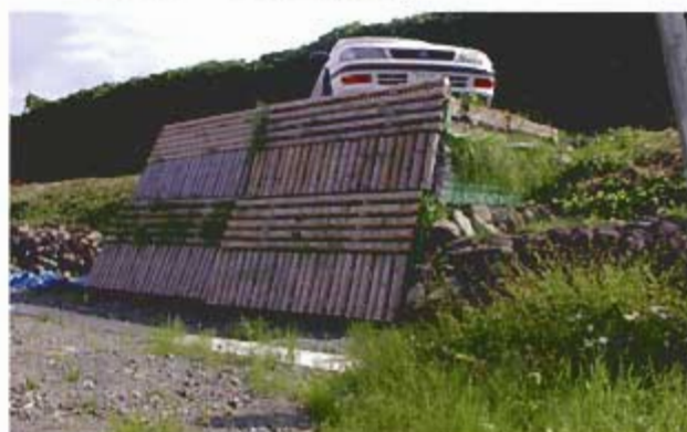
写真6. 試験施工、奥1：0.5、手前1：0.3
