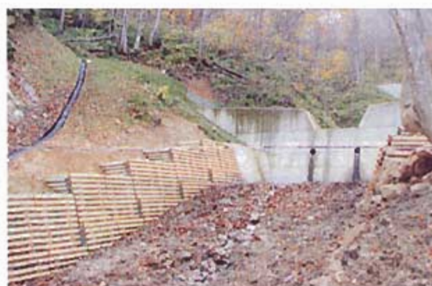
写真9. 事業適用例、河床勾配24%、落差工適用、2段構
