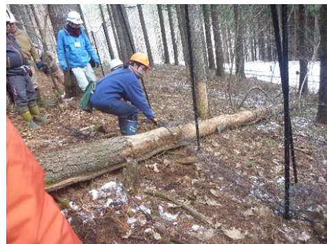
写真1 植生保護柵の設置実習。防護対策を実施するには，被害状況，費用対効果，地形的条件やシカの行動特性などを調査し，手法を選択する。
