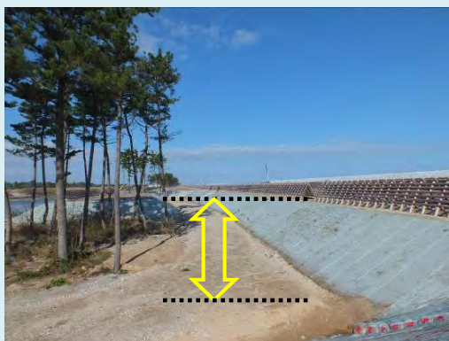
写真—1 海岸盛土造成地 (矢印:盛り土嵩上げ分)
