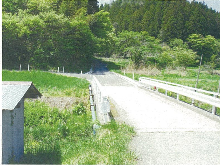
⑬国道456号から林道入口付近
