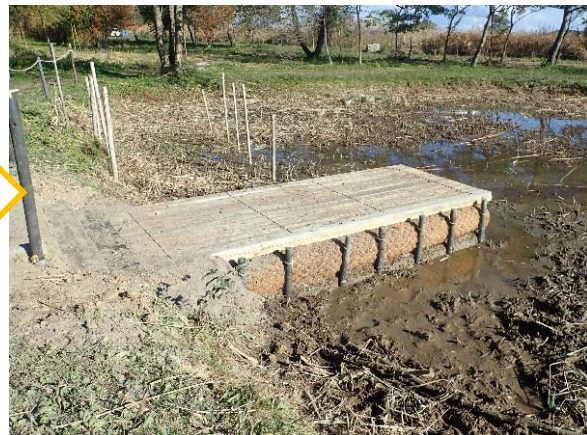
図3.2 観察足場の造成後
