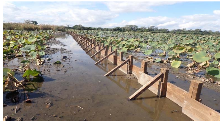
図7. エコトーン(板柵)を設置した様子.
