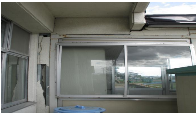
【食堂通路】外壁及び窓枠の状況
