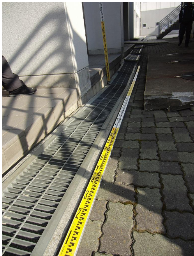
側溝の陥没
