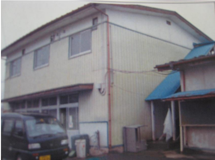
農業実習管理室
