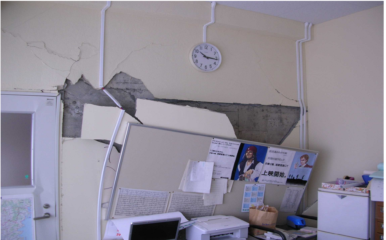
C棟 1階 司書室
