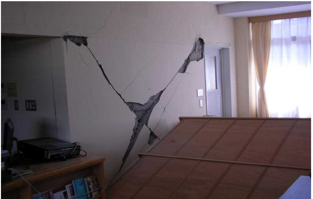
C棟 1階 図書室
