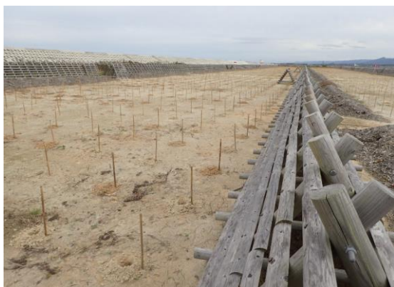
事前に位置出し及び穴開け作業実施
