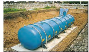
【耐震性貯水槽】
