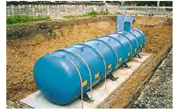
【耐震性貯水槽】
