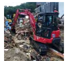
【重機によるガレキ撤去(広島県広島市)】
