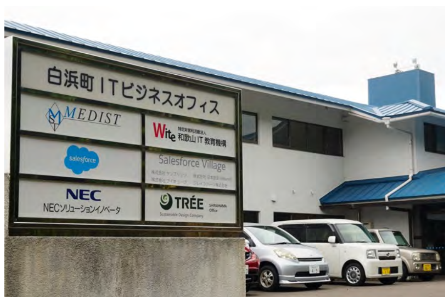
「白浜町ITビジネスオフィス」外観
