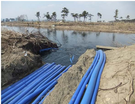
近接する赤江川への緊急排水状況
