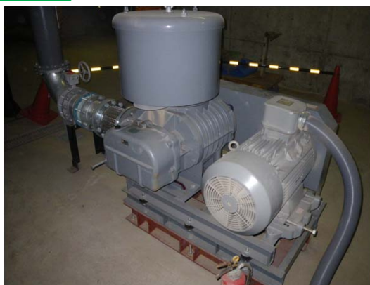
5系1/2水路への仮設曝気による簡易曝気実施
