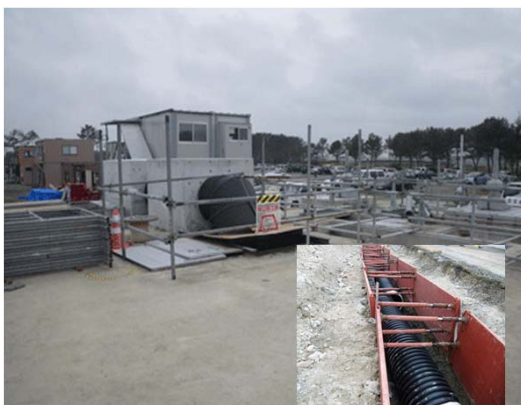
仮導水管による5系2/2水路への送水
