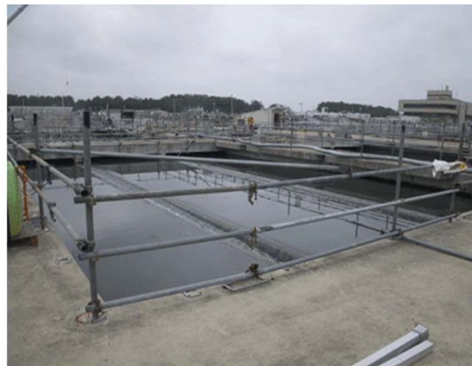
5系2/2最終沈殿池 簡易沈殿実施状況
