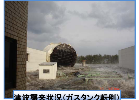
津波襲来状況(ガスタンク転倒)
