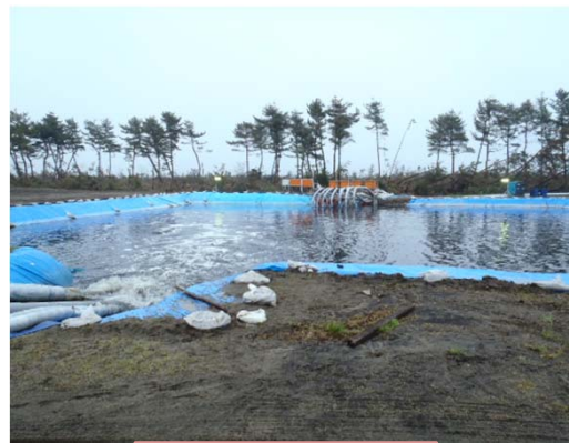
仮沈殿池設置状況
