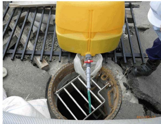
緊急排水のための簡易消毒実施状況
