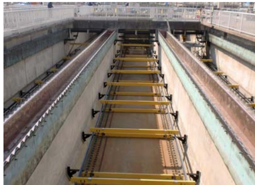
最終沈殿池復旧状況
