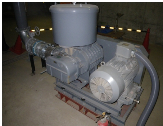
5系1/2水路への仮設ブローによる簡易曝気実施
