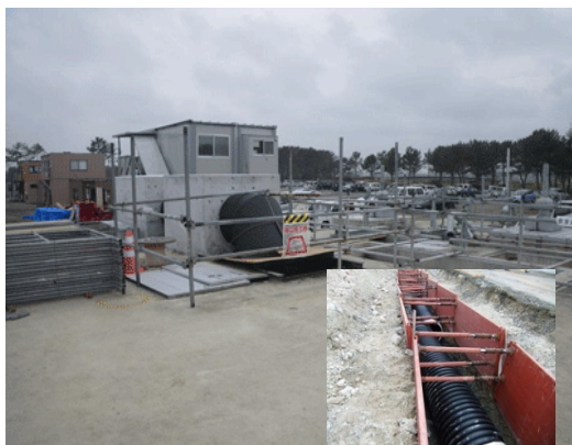
仮導水管による5系2/2水路への送水
