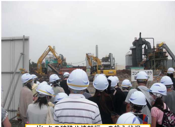
ガレキの破碎や焼却炉への投入状況
