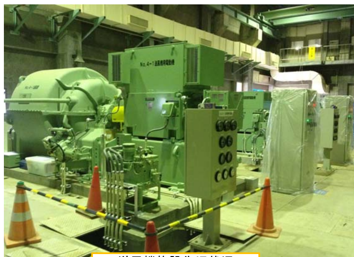
送風機施設復旧状況
