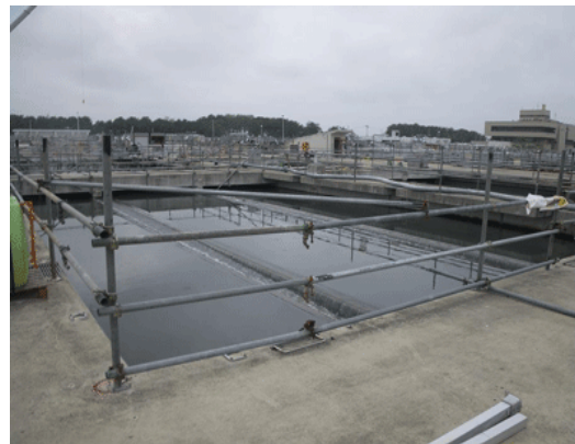
5系2/2最終沈殿池 簡易沈殿実施状況
