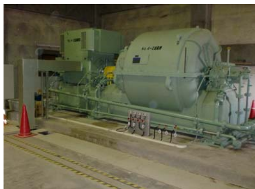
No.4-2送風機復旧・運転再開
