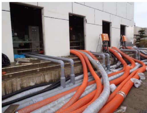
沈砂池ポンプ棟から仮沈殿池への仮設ポンプによる送水
