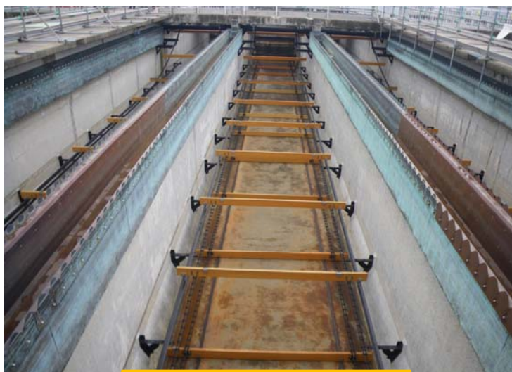
第3系列最終沈殿池復旧状況
