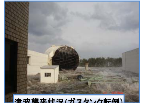
津波襲来状況(ガスタンク転倒)
