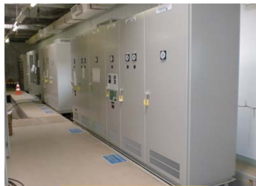
電気設備復旧状況
