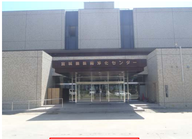
管理棟正面玄関復旧状況
