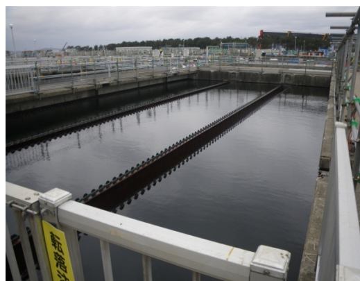
5系1/2最終沈殿池 簡易曝気実施状況
