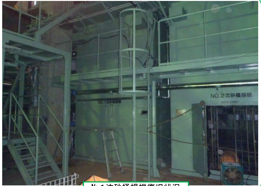
No.1沈砂掻揚機復旧状況
