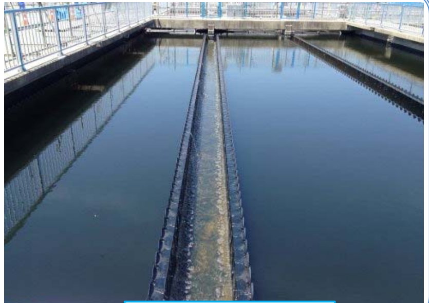
第4系列最終沈殿池復旧・処理状況
