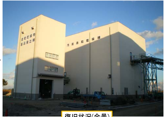
復旧状況(全景)
