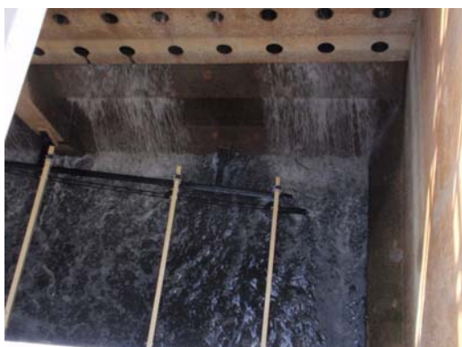
最初沈殿池流入開始状況
