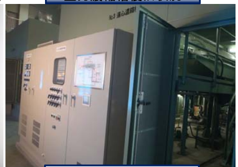
機械濃縮設備復旧状況
