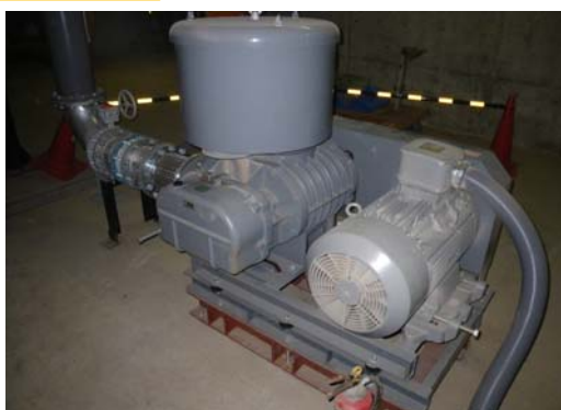
仮設フロアによる簡易曝気
