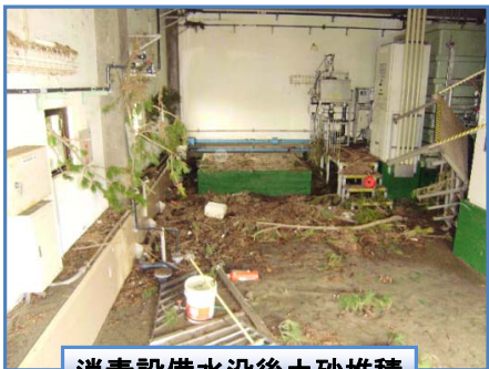
消毒設備水没後土砂堆積
