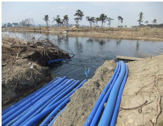
近接する赤江川への緊急排水状況
