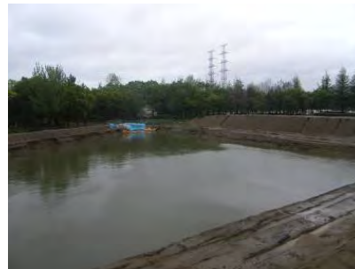
仮設沈殿池設置状況
