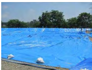
【シート覆工状況】
