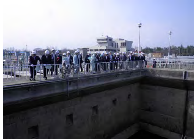
復旧工事視察(第1系列:復旧工事中)
