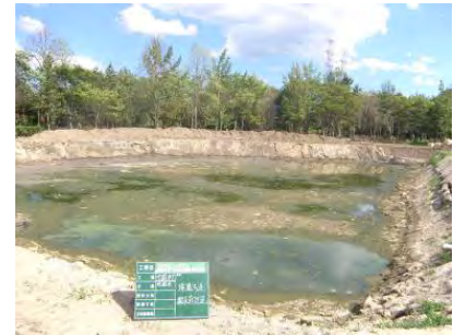
仮設沈殿池堆積状況
