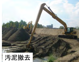
沈殿池撤去状況
