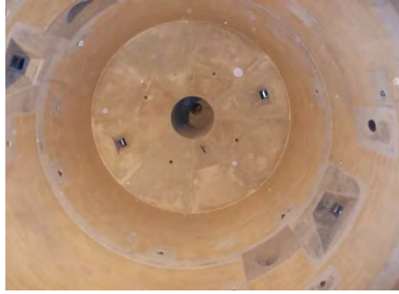
炉内復旧完了
