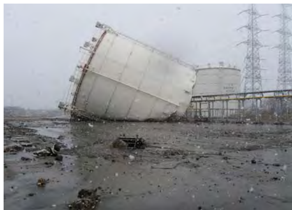
津波で流出したガスホルダーも3月中の復旧を目指して鋭意復旧工事中です。
