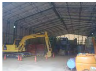
【テント内部 脱水作業】
