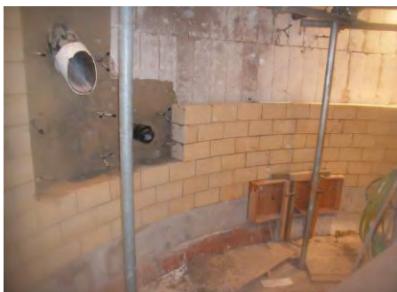
炉内耐火レンガ設置状況(8月頃)
