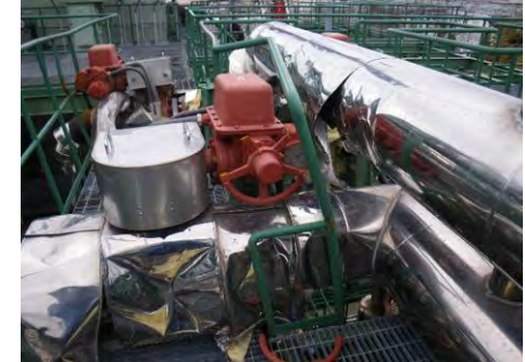
配管類損傷
