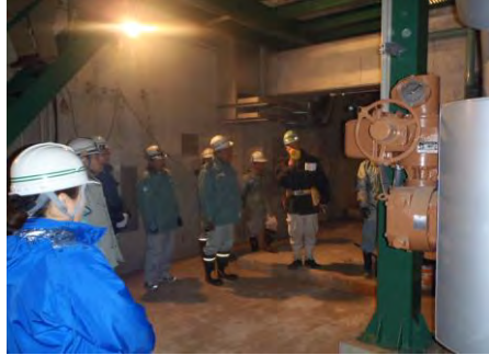
脱水汚泥搬送ポン
