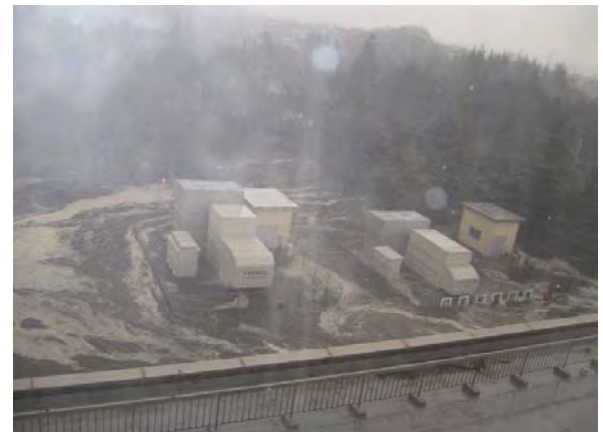
④自家用発電機(津波により機能停止)
