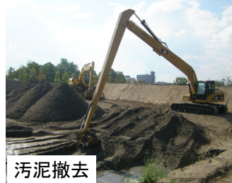
沈殿池撤去状況
