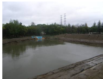
仮設沈殿池設置状況
