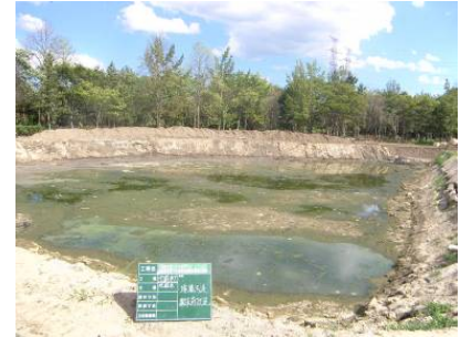
仮設沈殿池堆積状況
