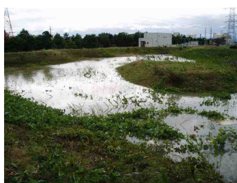
図-3 調整池の湛水状況
