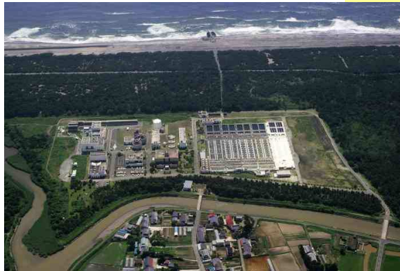
県南浄化センター
