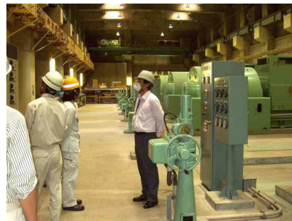
送風機設備の状況確認
