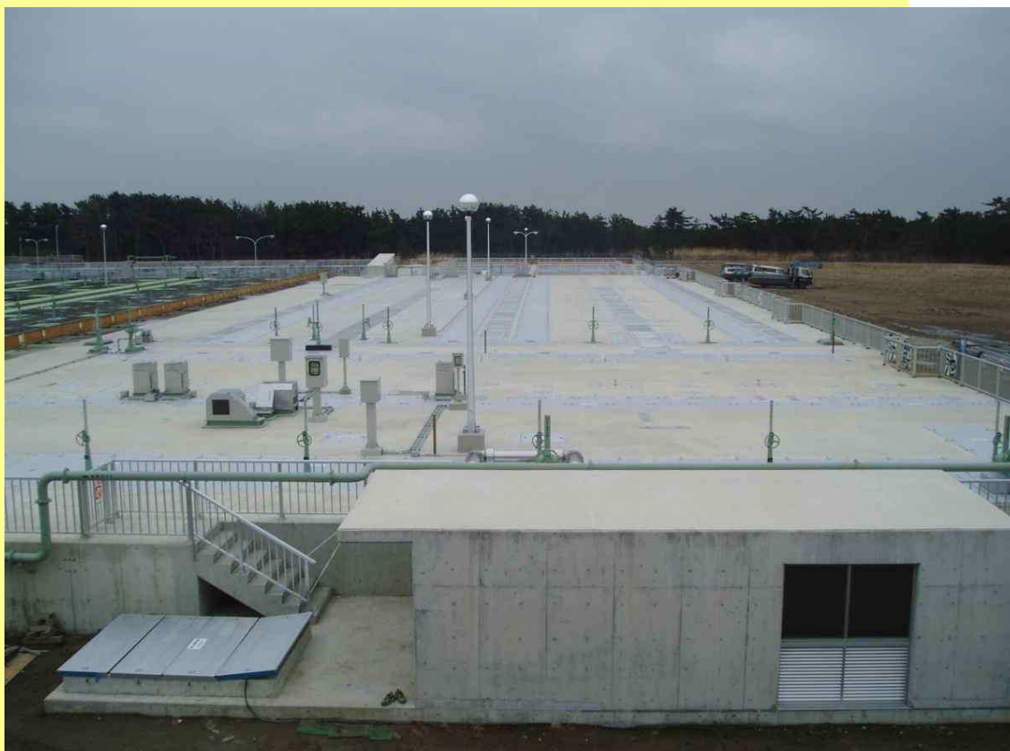
県南浄化センター水処理第5系列
