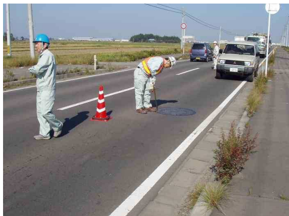
流域幹線のマンホール点検
