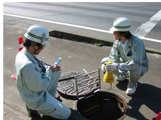
マンホール点検と災害携帯による画像転送訓練
