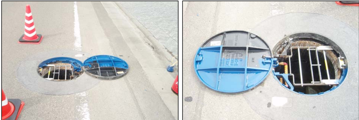
塗布後のマンホール蓋
