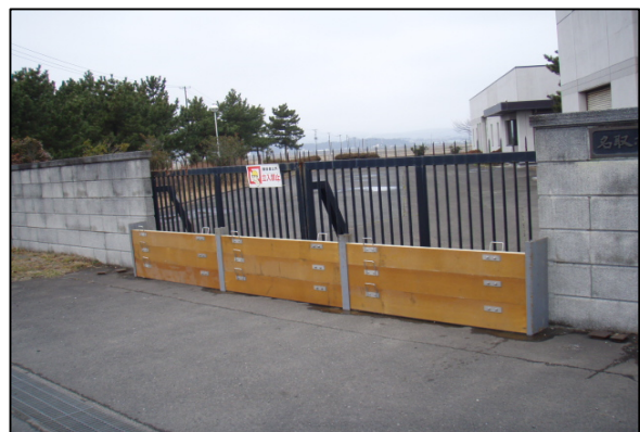
※名取ポンプ場正面ゲートの防水壁設置。
