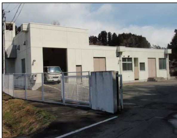
角田ポンプ場の外観
