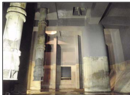
ポンプ井内の仕切壁
