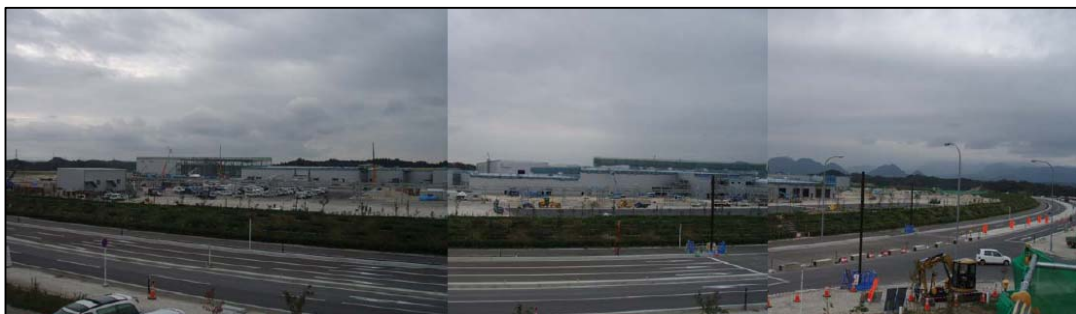
建設が進むセントラル自動車工場
