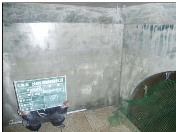
コンクリート増し打ち後の状況
