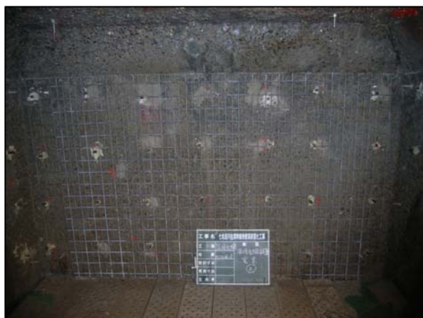
せん断補強鉄筋挿入後の状況
