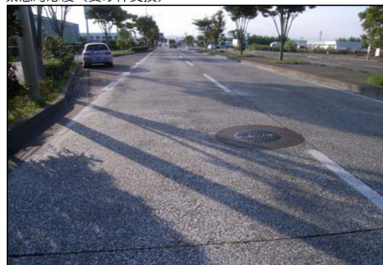
緊急対応後（受け枠交換）
