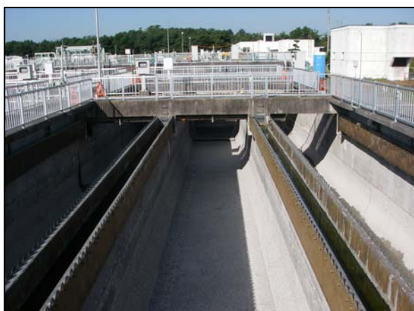
最終沈殿池全景（1系 1/2）
