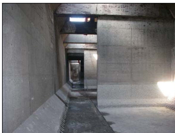
反応タンク内部の状況
