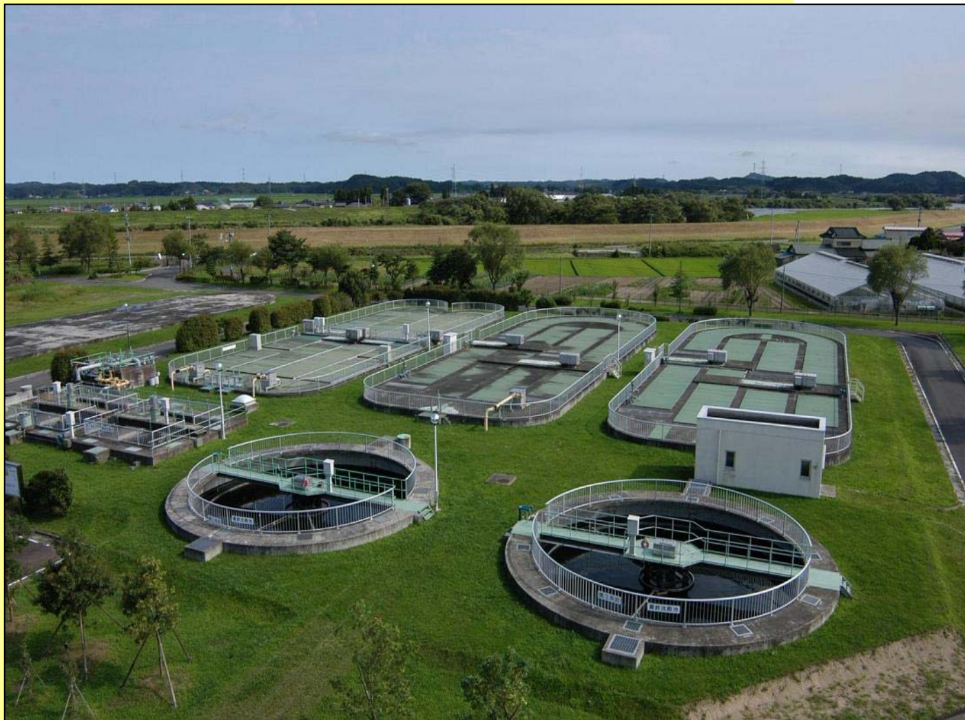
鹿島台浄化センター 水処理施設
